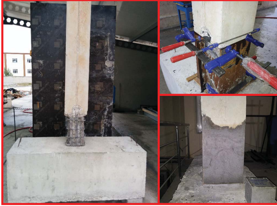
Şekil 11. Hasar görmüş kolon eleman için UYDLB ile güçlendirme uygulaması
