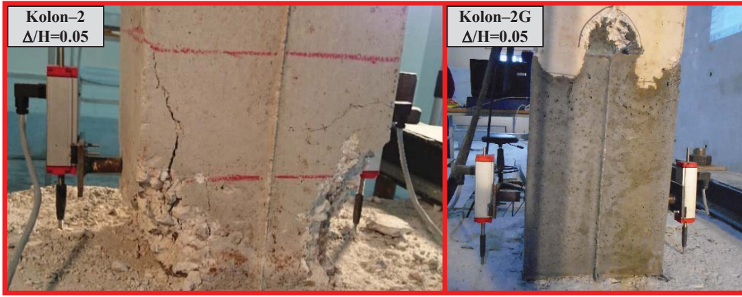
Şekil 18. Güçlendirme öncesi ve sonrası Kolon-2’deki hasar durumu ( \Delta/H=\%5.0 için)
