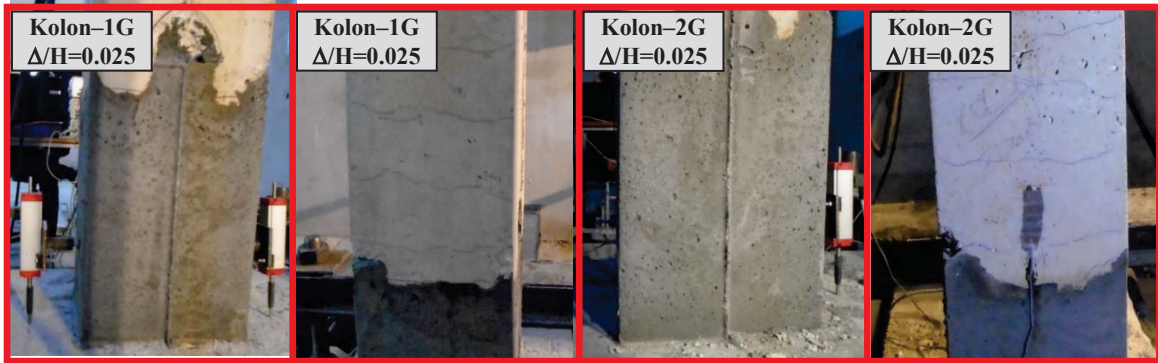
Şekil 15. Güçlendirme sonrası Kolon-1 ve Kolon-2'de oluşan hasarlar ( \Delta/H=0.025 için)
