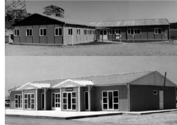
Pröfabrik olarak üretilmiş yemekhane ve çay salonu binası
